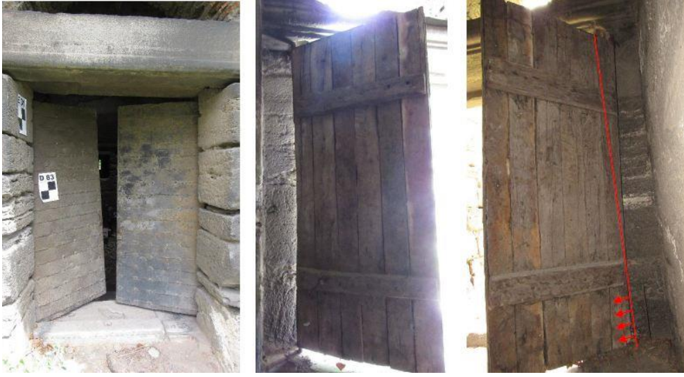
Kuzey Kule alt kapı mevcut durum genel görünümü
