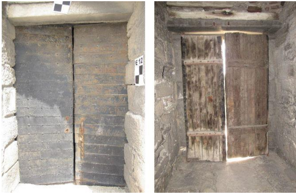
Kuzey Kule üst kapı mevcut durum genel görünümü
