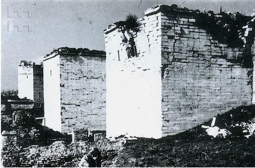
Yedikule Büyük Altınkapı, surların onarımdan önceki durumu Cahide Tamer Arşivi.
