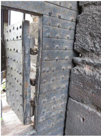
Farklı boyutlardaki dövme demir perçinler ve perçin yuvaları
