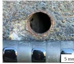
Farklı boyutlardaki dövme demir perçinler ve perçin yuvaları
